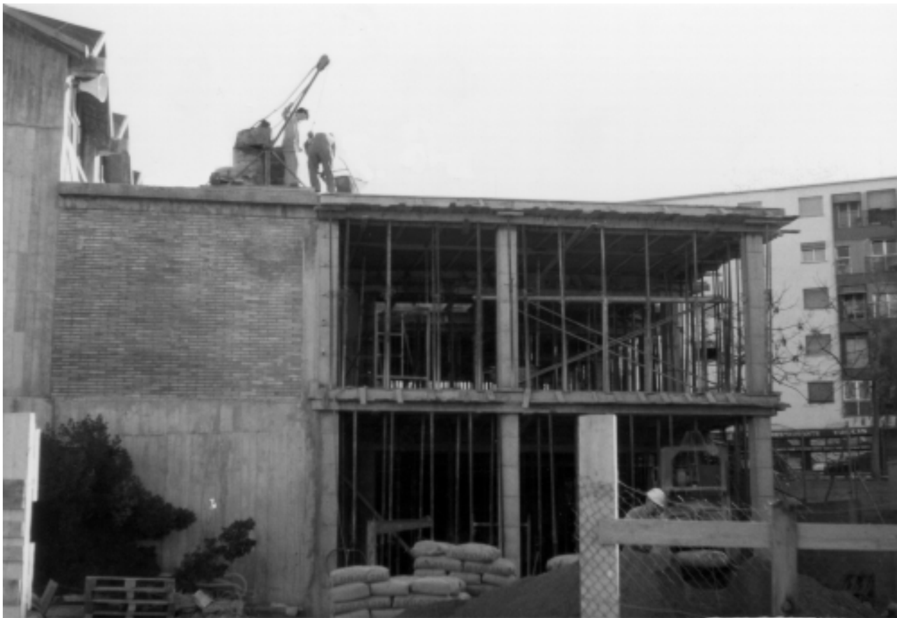
26 de desembre de 1984. Obres de construcció del Centre de Pastoral Sescelades i de la nova rectoria
