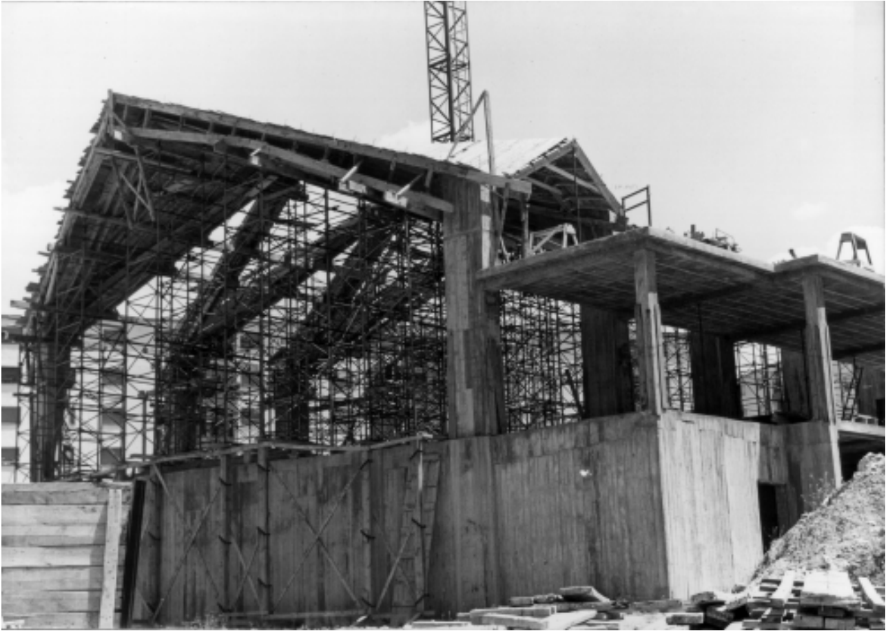
Any 1974. La parròquia en construcció
